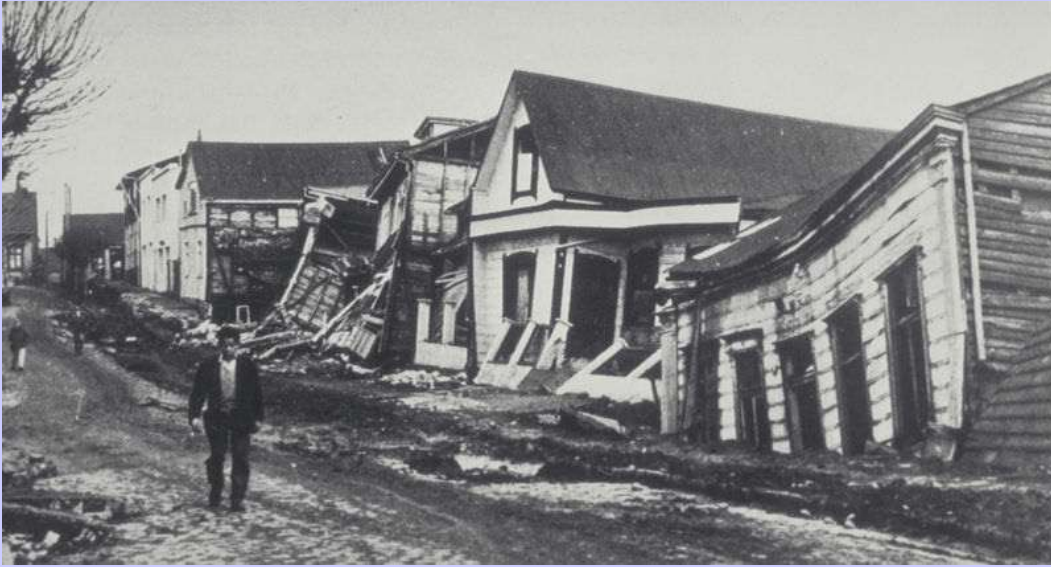
Rue de Valdivia (700 km S de Santiago) après le séisme
